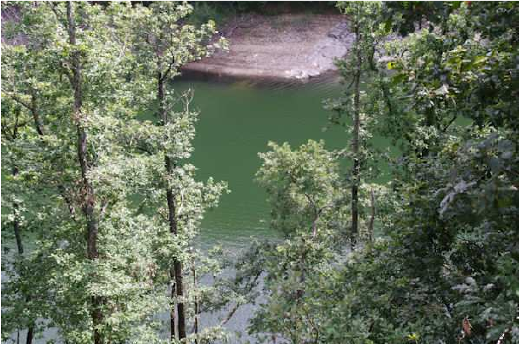
Barrage des Cammazes
