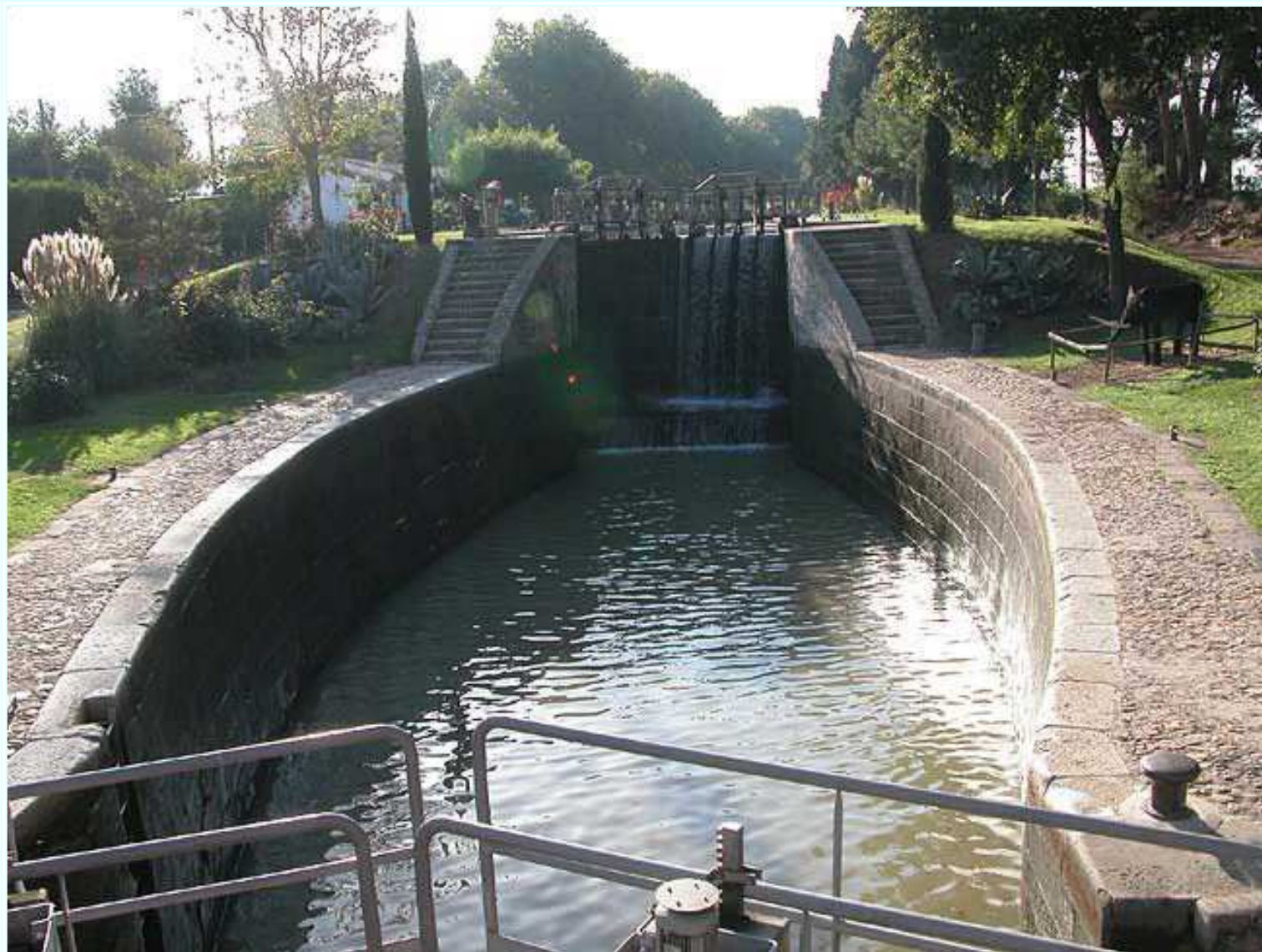
Ecluse du Canal du Midi
